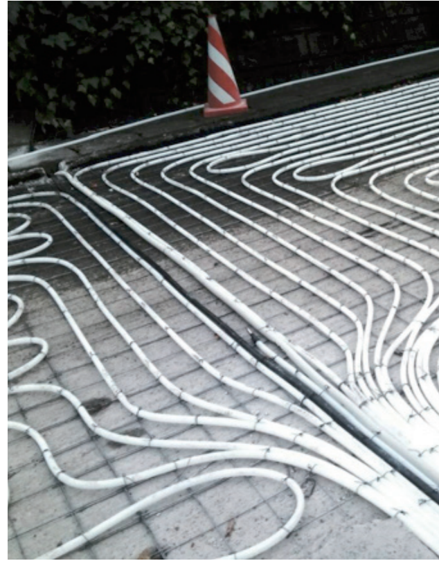
温水式コンクリート埋設工法 (放熱管、架橋ポリエチレンパイプ) (アスファルト埋設、アルミコーティングパイプ)
